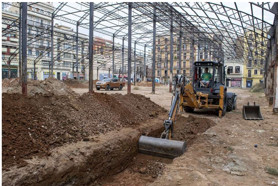
Vista dels treballs d'excavació de les rases de sondeig
